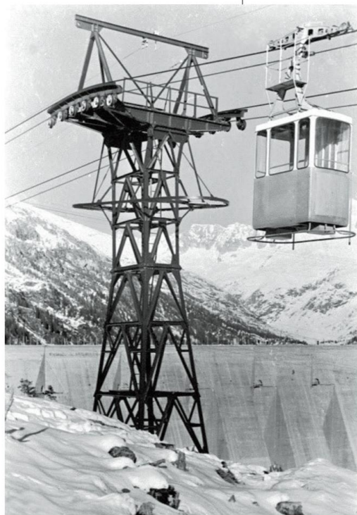
1957, el teleférico de servicio del guardián de la presa, de Malga Boazzo a Malga Bissina. (ph. propiedad de Enel)
