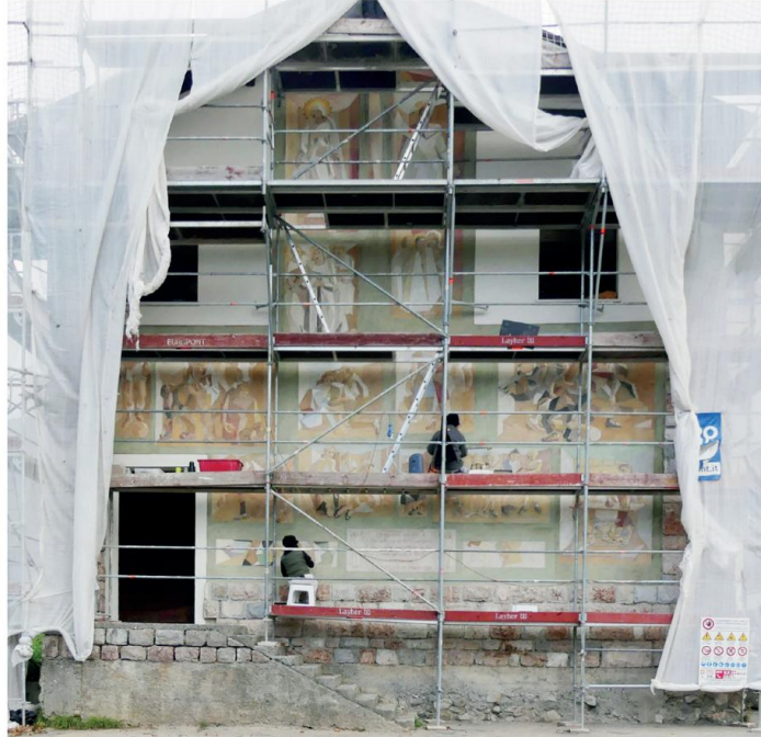
Andamios para la restauración de fachada.
